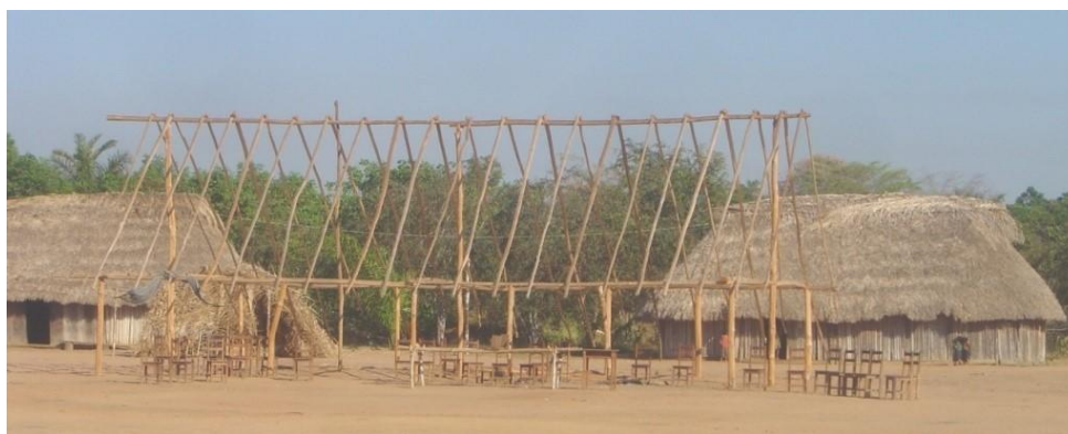
Foto: 44: Casa do caxiri em construção
