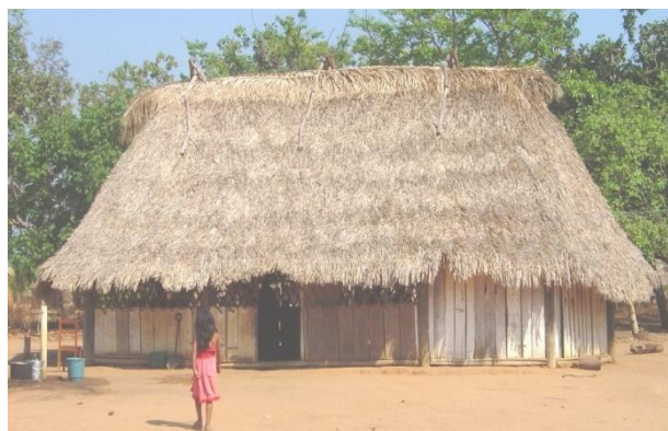
Foto 43: Cozinha da escola Kamadu
