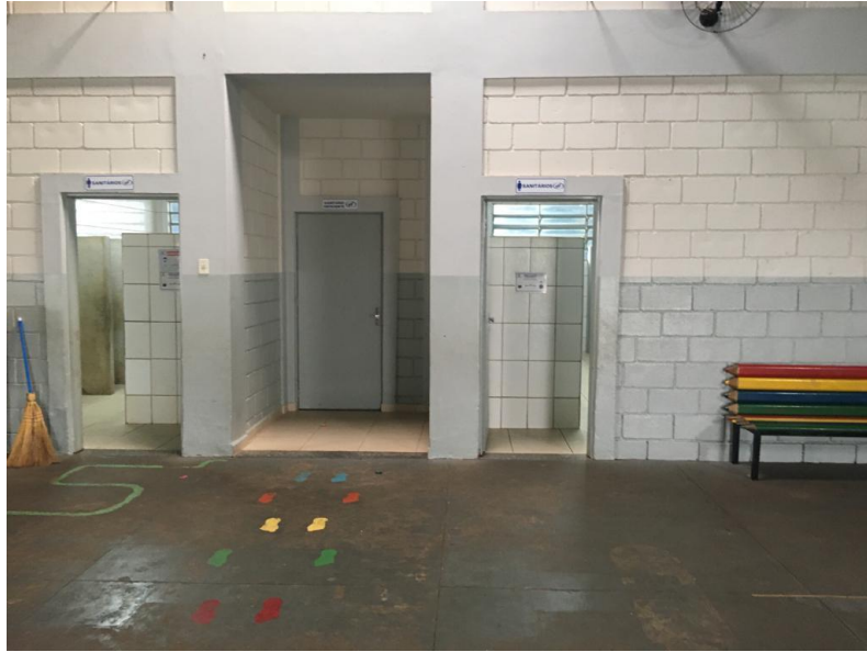
Foto 4: Sanitários – escola “Maria Firmina dos Reis” À esquerda: feminino, ao meio: para pessoas com deficiência, e à direita: masculino. Fonte: Acervo da pesquisadora.
