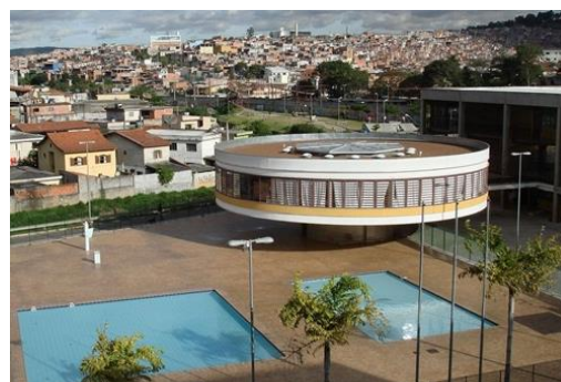
Figura 2 – Prédio do CEI
