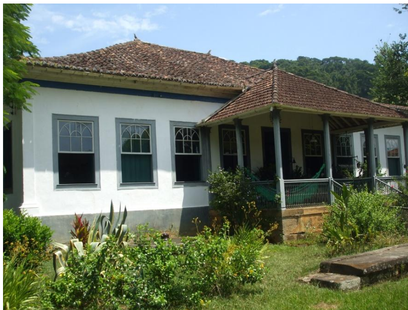
Fotografia 4 - Fachada da Fazenda Coqueiros
