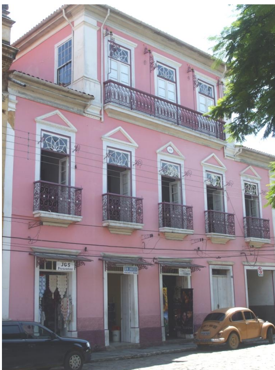
Fotografia 10 - Fachada do Antigo Clube Literário
