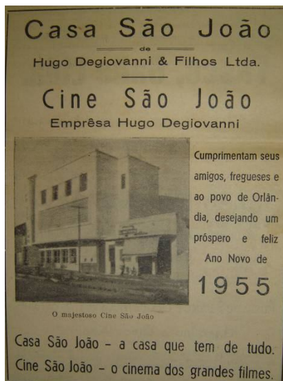
Fonte: Casa São João e Cine São João (1955)
