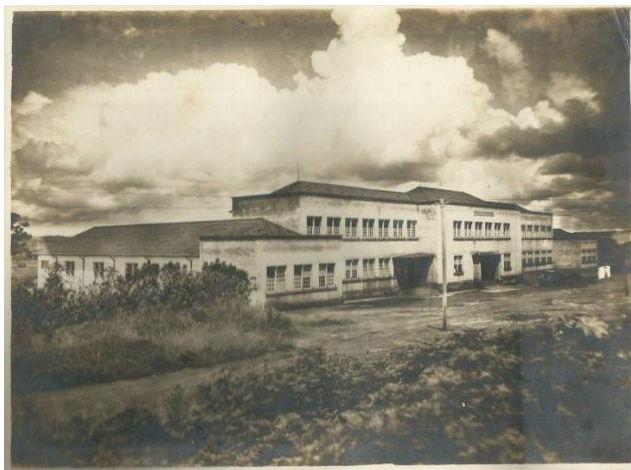
Figura 15 – Prédio do Ginásio Estadual de Orlandia
