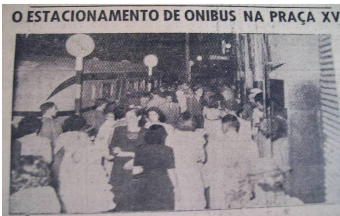
Figura 17: Terminal de ônibus da Praça XV
