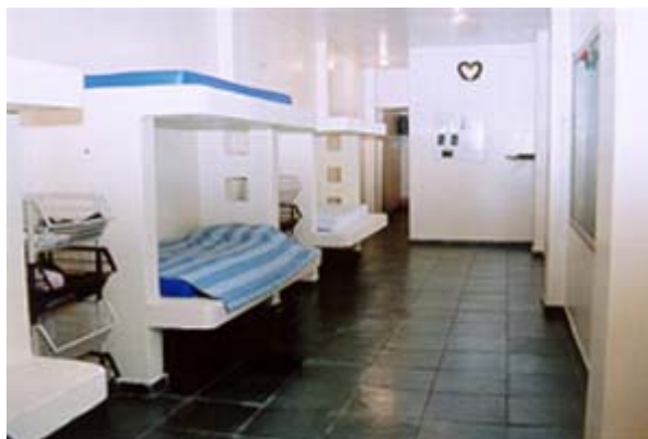
Figura 2. UIP – Unidade de Internação Provisória, com capacidade para seis adolescentes. 16
