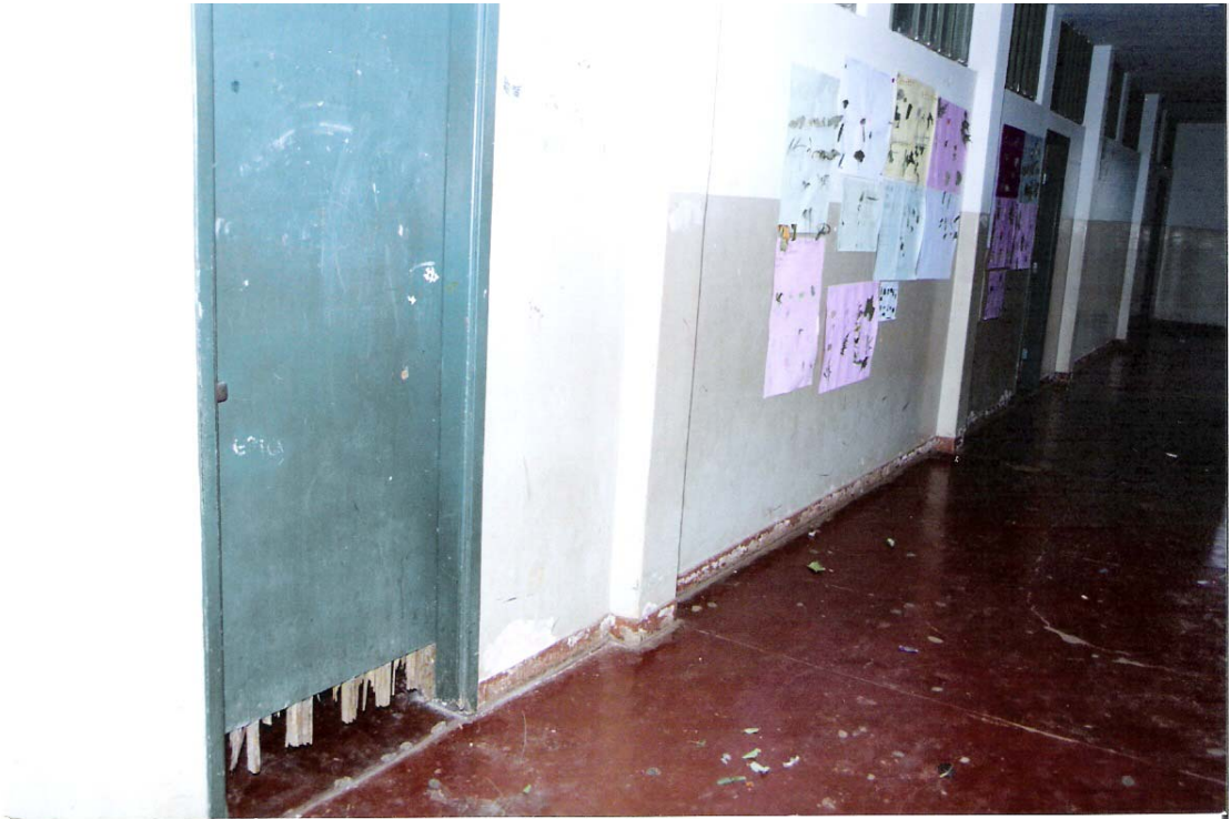
Figura 1- Vista do corredor e da porta de entrada que dá acesso à sala observada
