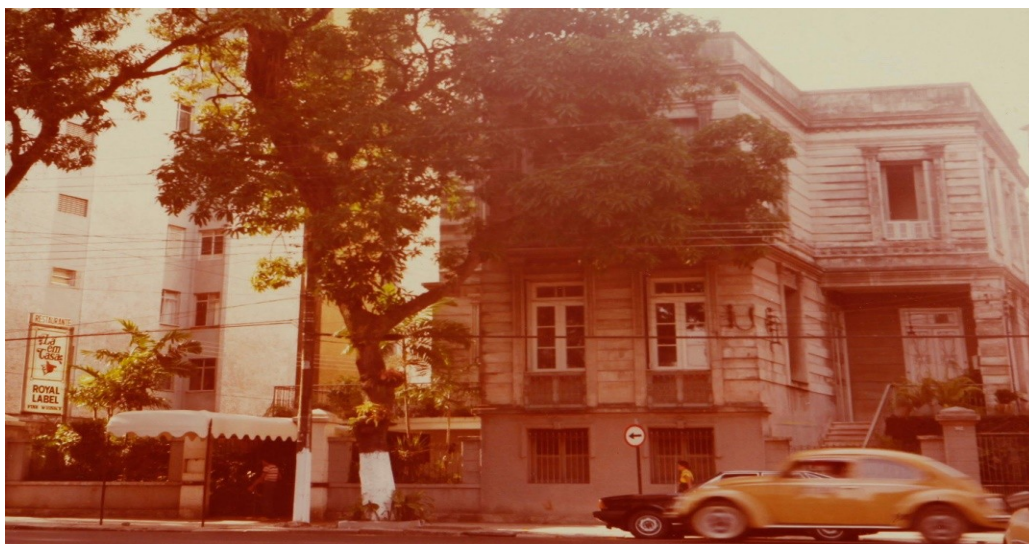
Figura 19: Retrato do Restaurante Lá em Casa, na década de 1970, localizado na Avenida Governador José Malcher, em Belém. Atualmente o casarão se encontra totalmente reformado e nele funciona uma agência bancária.
