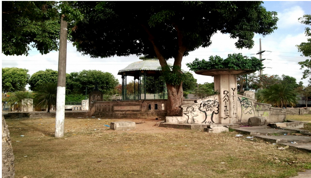
Figura 15: Praça General Magalhães, em Belém, antes da revitalização pelo projeto “Belém Porto Futuro”.
