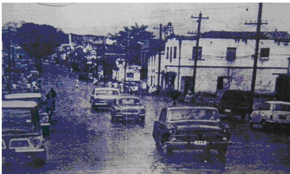
Foto 08: Primeira camada asfáltica na Rua Cândido Mendes no ano de 1960. Fonte: Casa da Cultura.
