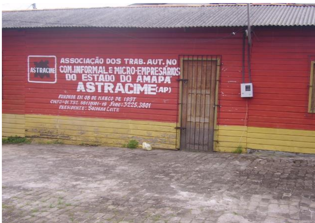
Foto 29: Fachada Externa da ASTRACIME Fonte: Pesquisa de campo, 2008.
