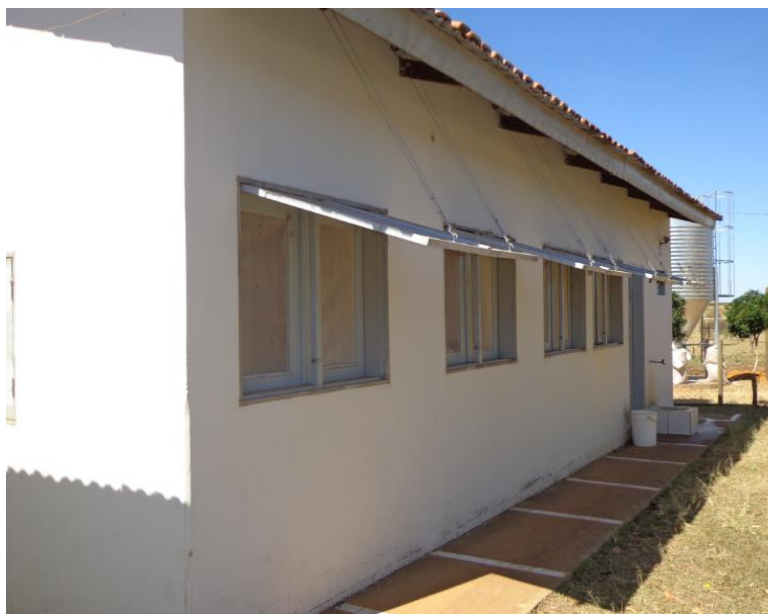
Foto 4. O quarto de queijo, construção de alvenaria.
