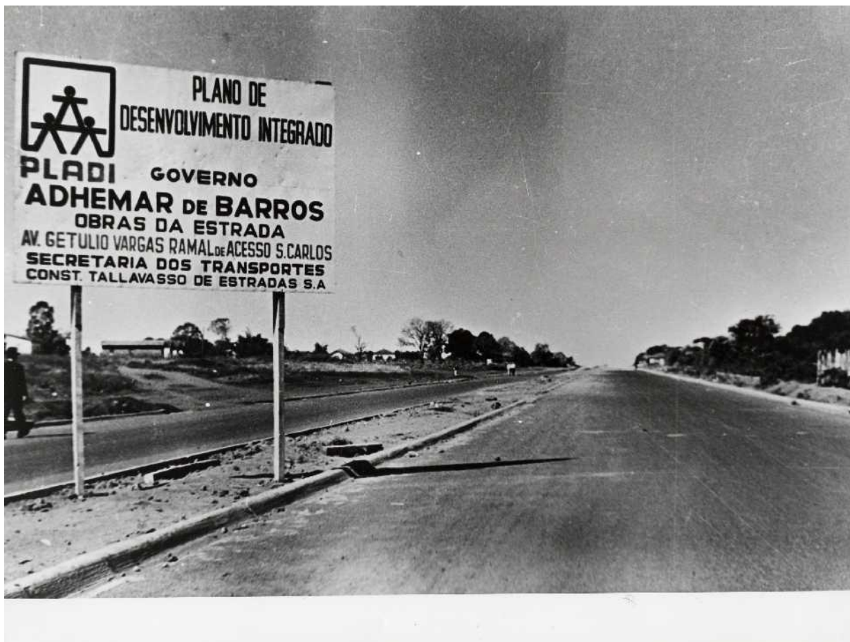
Figura 6 - Foto das obras da Avenida Getúlio Vargas em 1950
