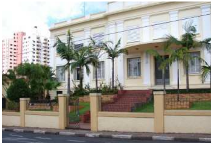
FACHADA DO COLÉGIO PROGRESSO
